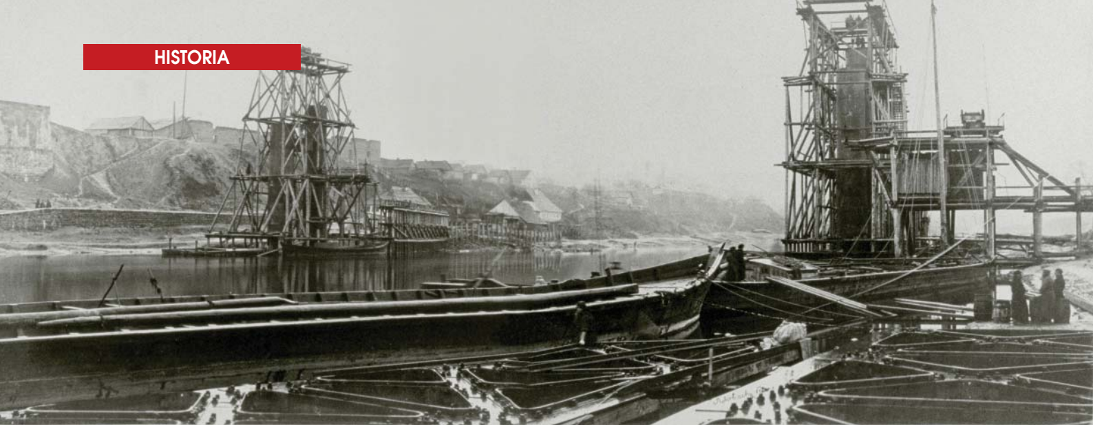
BUDOWNICTWO MOSTU KOLEJOWEGO NA ZDJĘCIU, ZROBIONYM PRZEZ ANTONA ROHRBACHA. LISTOPAD 1861 R.
