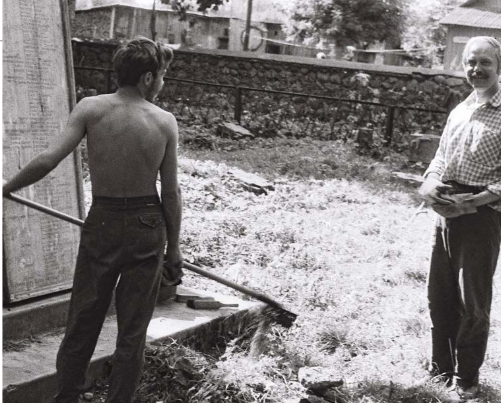
1987 R. LIDA. PRACE PORZĄDKOWE NA CMENTARZU PRZY UL. ENGIELSA. FOT. ZE ZBIORÓW A. KOLYSZKI
