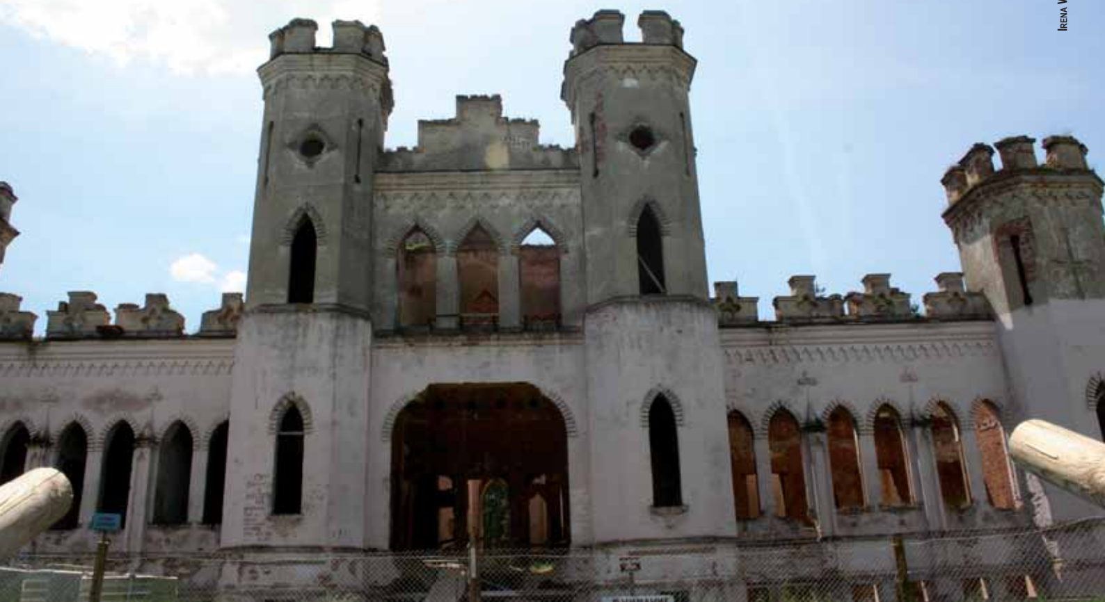
PAŁAC PUSŁOWSKICH W KOSOWIE POLESKIM, SPALONY PRZEZ PARTYZANTÓW SOWIECKICH W 1942 R. OBECNIE TRWAJĄ TU PRACE REMONTOWE
