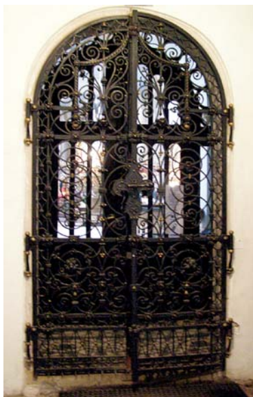
Krata wejścia głównego
