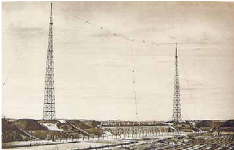
Stacja nadawcza Polskiego Radia, budowana na Forcie Mokotowskim. Rok 1926
