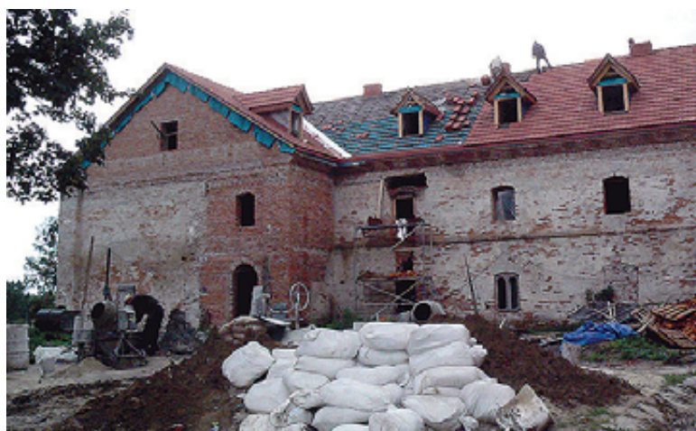
Na odbudowanym skrzydle kościoła trwają roboty przy pokryciu dachu. Trzeba zdążyć przed zimą
