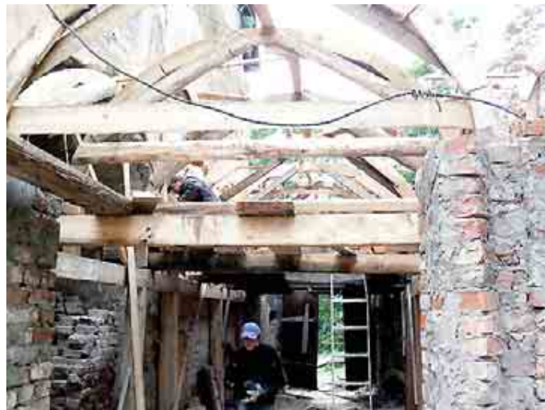
Trwa odbudowa łącznika pomiędzy klasztorem a kościołem
