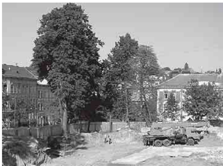
Plac budowy konsulatu RP we Lwowie
