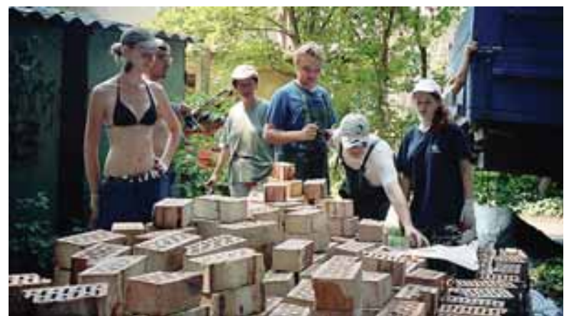
Przyjechała cegła do odbudowy muru cmentarnego
