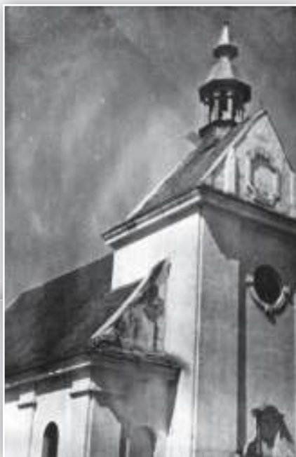
Kościół przed remontem
