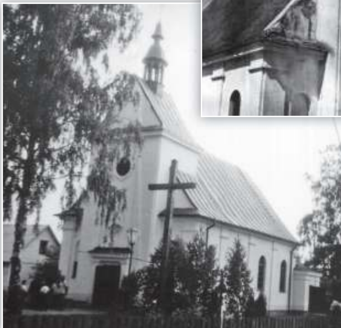
Kościół po remoncie, 1995 r.
