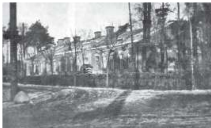
Budynek dowództwa Nowogródzkiej Brygady Kawalerii (lata trzydzieste)
