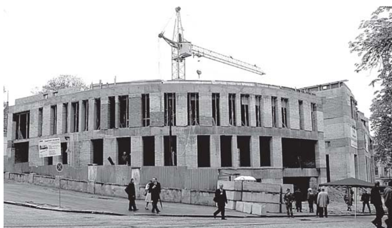
W budowie gmach Konsulatu RP we Lwowie
