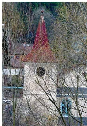
Wieża kościoła parafialnego pw. Wniebowzięcia NMP, który przez reżim komunistyczny został zrujnowany
