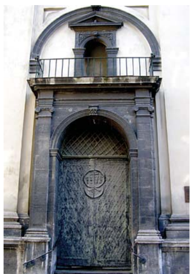
Portal wejścia głównego
