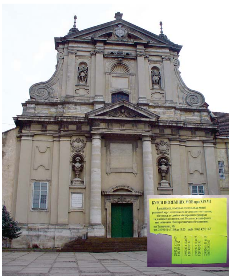
Kościół Matki Bożej Gromnicznej. Przy drzwiach umieszczona informacja o płatnych kursach języków obcych
